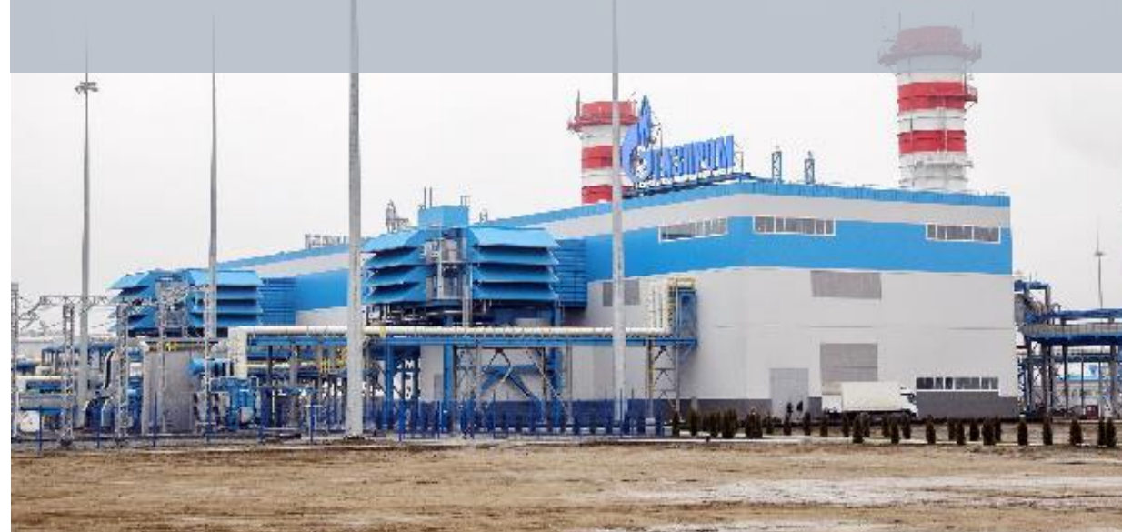
Газпром Грозненская ТЭС, Амурский ГПЗ
