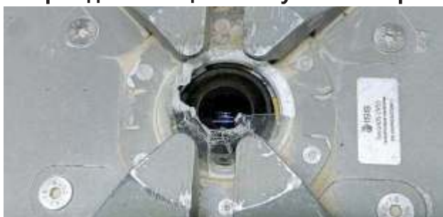
Повреждение защитного купола камеры
