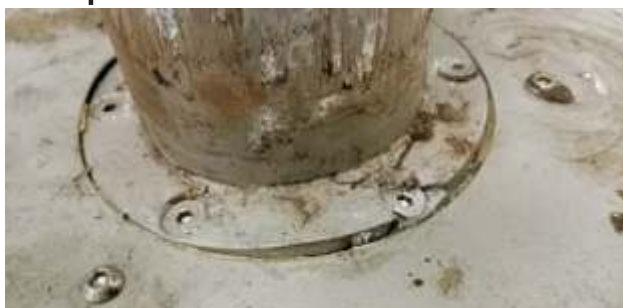
Царапины на защитном куполе камеры, приводящие к снижению качества изображения
